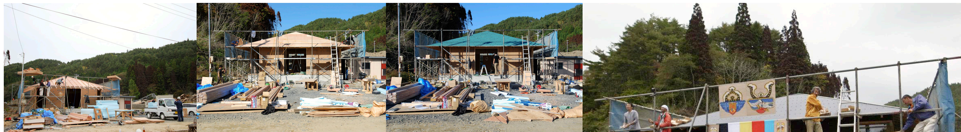
10/19 A 垂木施工
